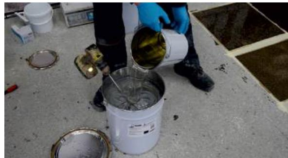
2. Добавить компонент В (отвердитель) в ёмкость с перемешанным компонентом А. Тщательно перемешать смесь еще в течение 3 минут до получения однородной массы.
