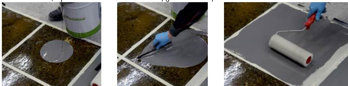
После распределения материал следует раскатать с помощью игольчатого (деаэрационного) валика. Это позволяет облегчить выход воздуха и процесс растекания материала по поверхности.
